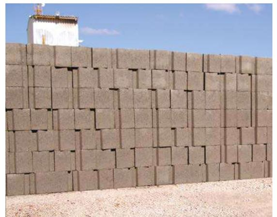
Figura 6.22 Estiba de bloques de entripiso en sitio
