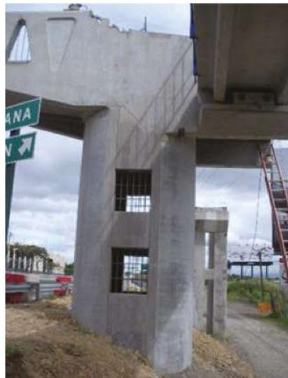
Figura 13.12 Bastión prefabricado en puente peatonal Multiplaza Escazú
