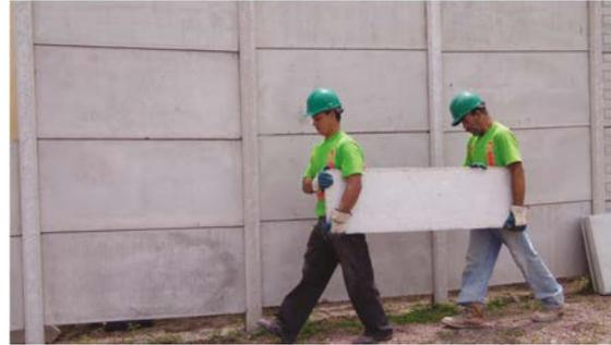
Figura 9.49 Correcta manipulación de las baldosas
