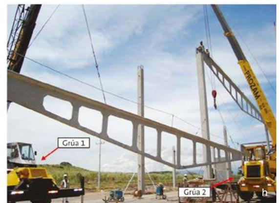
Figura 10.34 Almacenamiento e izaje de columnas
