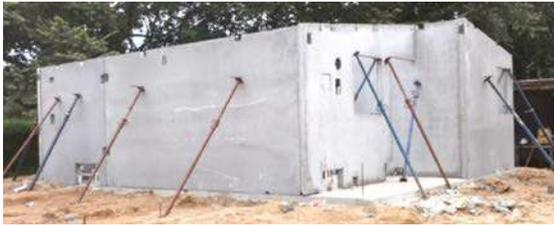
Figura 16.6 Apuntalamiento lateral de paredes de paneles prefabricados
