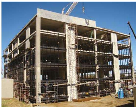
Figura 11.6 Columnas de varios niveles permiten trabajar simultáneamente en varios pisos (edificios Zona Franca América)
