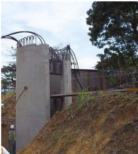
Figura 13.11 Bastión prefabricado en puente peatonal Río Oro
