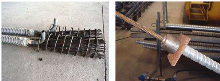
Figura 14.4 Anclajes fijos y detalle de anclaje vivo
