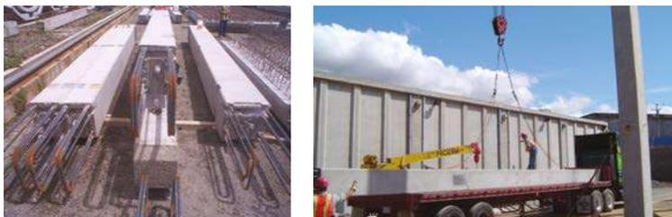
Figura 10.33 Almacenamiento e izaje de columnas
