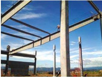
Figura 10.7 Nave industrial con luces de hasta 31 m y marcos cada 12 m, con viga de techo de alma llena invertida y Lex-panel como cerramiento en los ejes de amarre
