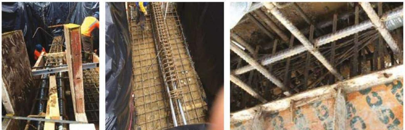
Figura 14.12 Postensado de vigas de Fundación, Parque Acobo, San Pedro
