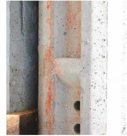
Figura 9.5 Detalle de ménsula para apoyo de primera baldosa
