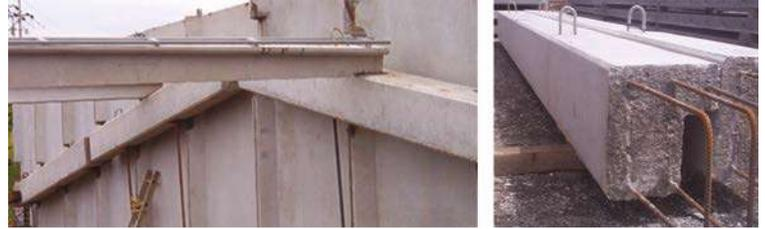
Figura 10.29 Vigas ménsula con la unión sin colar. Se nota la pendiente del 14% para la cubierta de techo.
