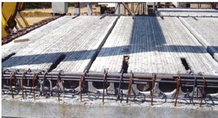
Figura 6.33 Apoyo de Losa Lex sobre la viga
