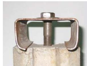
Figura 9.21 Detalle de conexión con solera
