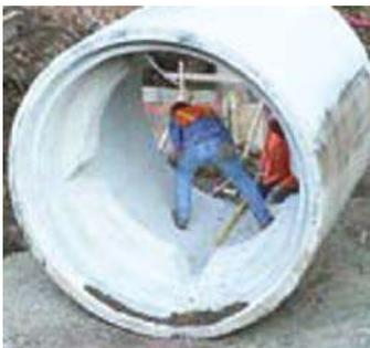
Figura 1.2 Ejemplo de tubería con disipador de energía.
