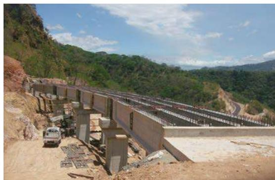
Figura 14.6 Vigas sobre puente Salitral
