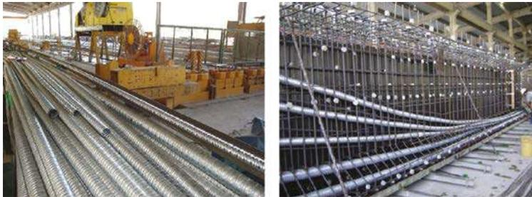
Figura 14.3 Ductos metálicos para el enhebrado de cables
