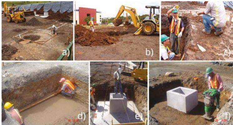
Figura 10.32 Instalación de placas: a) Trazado b) Excavación c) Revisión de niveles d) Sello de concreto pobre e) Montaje y f) Compactación
