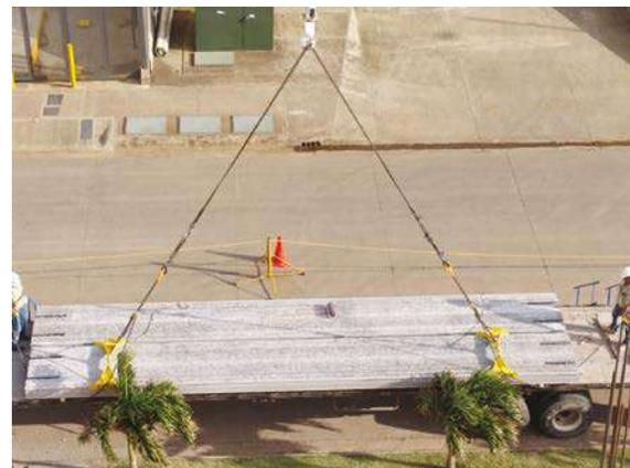
Figura 6.29 Detalle de dispositivo en pares para izaje
