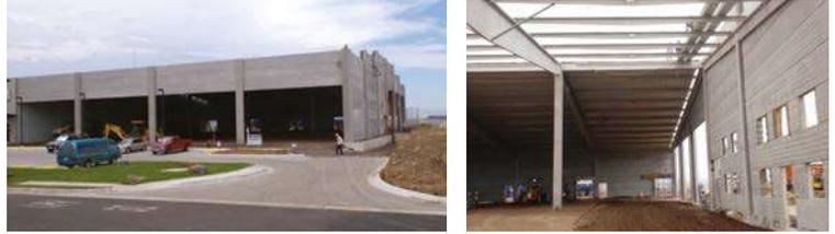
Figura 7.13 Edificios con Losa Lex como cerramiento horizontal
