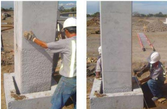
Figura 10.14 Acabado rugoso de la base de la columna
