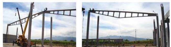
Figura 10.6 Nave industrial con luces de hasta 31 m y marcos cada 12 m, con viga de techo de alma abierta en colocación invertida y paneles verticales de cerramiento en los ejes externos
