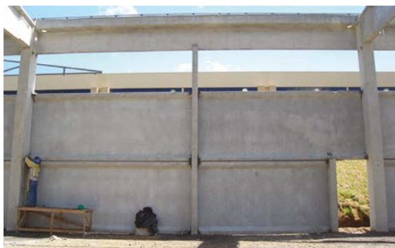
Figura 7.9 Pared de paneles horizontales soportados en columnas principales y con columna de pared intermedia
