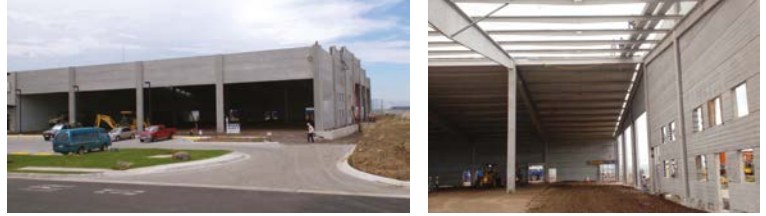
Figura 7.13 Edificios con Losa Lex como cerramiento horizontal
