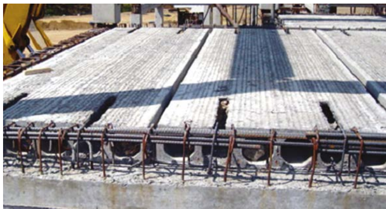
Figura 6.33 Apoyo de Losa Lex sobre la viga
