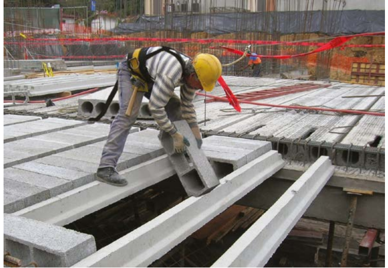
Figura 6.24 Colocación de bloques de entrepiso en las viguetas
