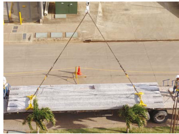
Figura 6.28 Detalle de dispositivos para izaje
