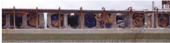
Relleno de celdas con sacos de cemento
