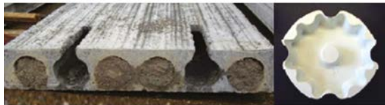
Relleno de celdas con concreto Tapa plástica
