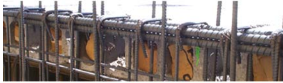
Relleno de celdas con cartón
