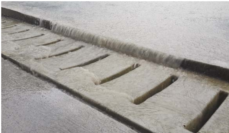
Figura 17.3 Parrillas de concreto
