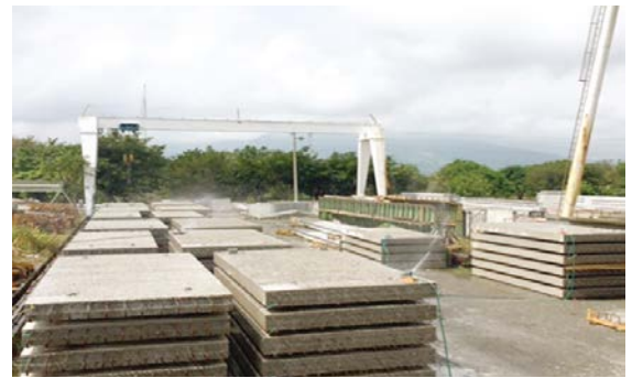
Figura 15.1.2 Prefabricado para Proyecto de APM Terminales en Limón
