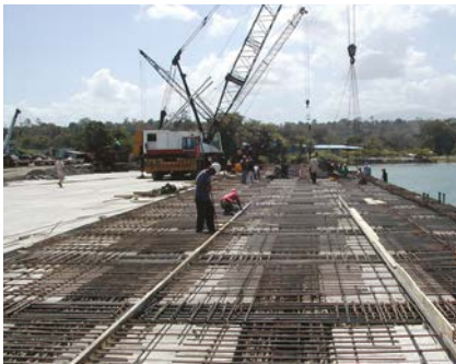
Figura 15.1.1 Muelle taiwanés en Limón. a) Pavimento de concreto. b) Pilotes de concreto.
