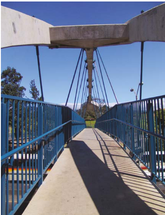
Figura 13.2 Puente peatonal tipo arco
