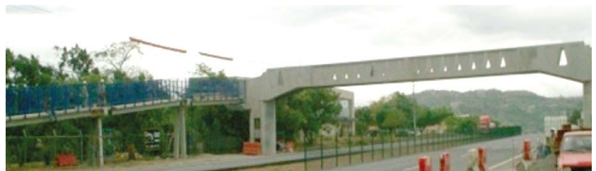
Figura 13.18 Puentes peatonales sobre la ruta 27 Santa Ana
