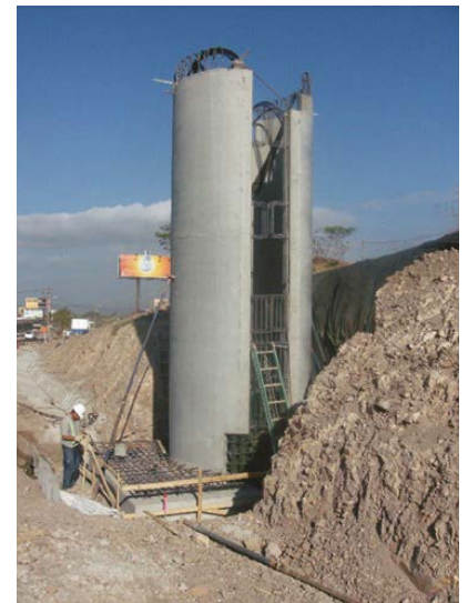
Figura 13.13 Bastión prefabricado en puente peatonal Pozos de Santa Ana
