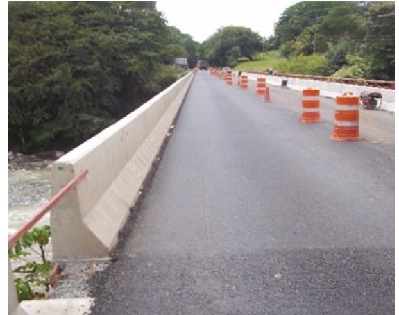
Figura 15.7 Ejemplo de barandas prefabricadas de concreto sobre puente Río Aranjuez
