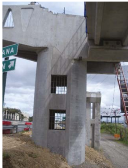
Figura 13.12 Bastión prefabricado en puente peatonal Multiplaza Escazú
