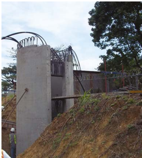
Figura 13.11 Bastión prefabricado en puente peatonal Río Oro
