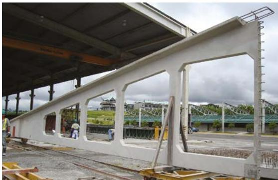
Figura 10.15 Viga de techo de alma abierta (Virendel)
