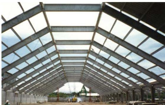
Figura 10.1 Nave industrial Abopac, récord nacional en concreto, por sus luces de 50 metros
