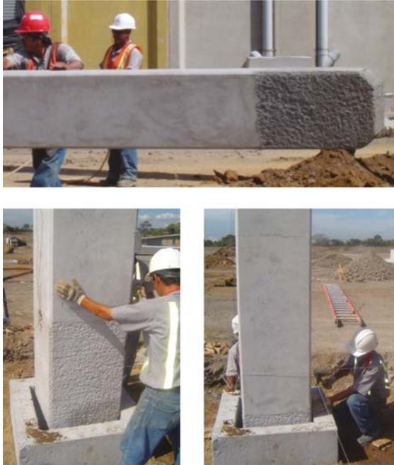
Figura 10.14 Acabado rugoso de la base de la columna
