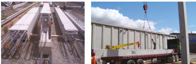
Figura 10.33 Almacenamiento e izaje de columnas
