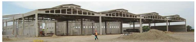
Figura 10.30 Uso de monitores de concreto en nave industrial Durman Esquivel, Coyol de Alajuela
