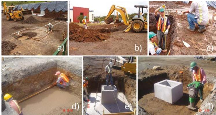
Figura 10.32 Instalación de placas: a) Trazado b) Excavación c) Revisión de niveles d) Sello de concreto pobre e) Montaje y f) Compactación
